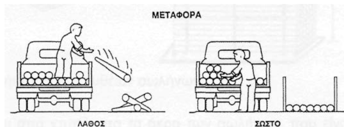
Σχήμα 3.10: Ανορθόδοξος και σωστός τρόπος φορτοεκφόρτωσης σωλήνων.
