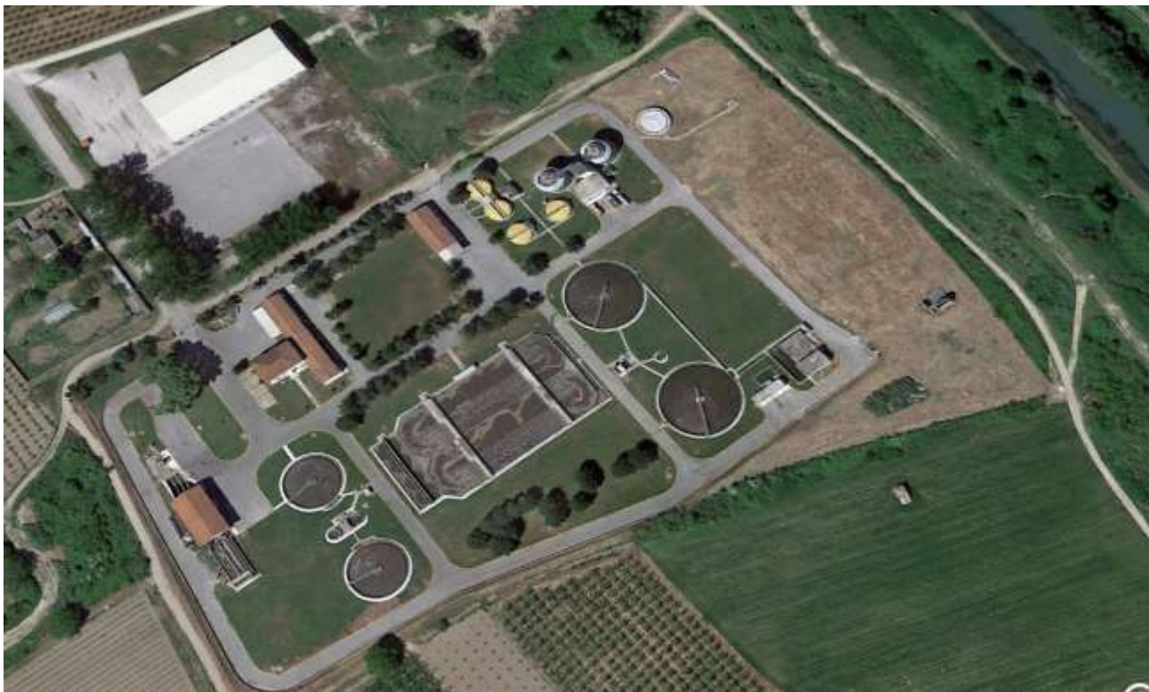
Εικόνα 1: Εγκαταστάσεις βιολογικού καθαρισμού ΕΕΛ Βέροιας
